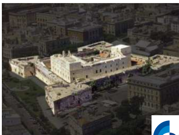
Castello Carlo V – Veduta Aerea
